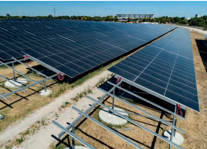
Fondations circulaires (centrale de Labarde, Bordeaux)
